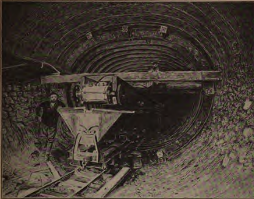
Fig. 314. — Chargement des wagons à l'aide du transporteur.
